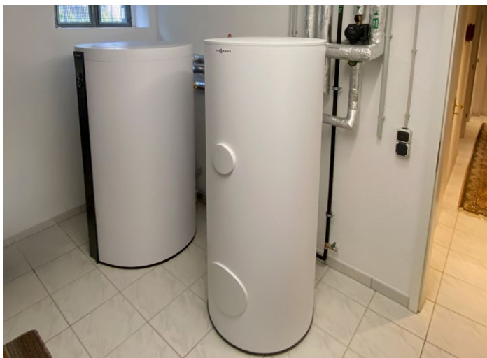
Inneneinheit Vitocal 250-SH und Puffer- mit Warmwasserspeicher
